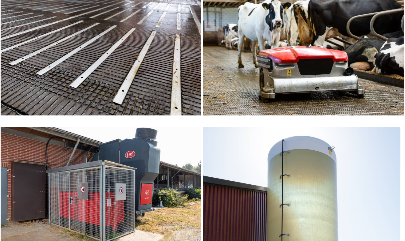
Figur 3.3: Øverst tv: Spaltestrimler med huller for dræning af ajele til gyllekanal. Øverst th: Gødningsrobot fjerner gødning afsat på gulvet. Nederst tv: Kemisk luftrensener monteret med indstik til gyllekanal. Nederst th: Silo for opbevaring af gødningskoncentrat fra luftrensener.
