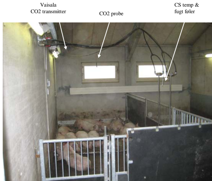
Figur 9. Temperatur, fugt og CO2 følerplacering i forsøgssektionen
