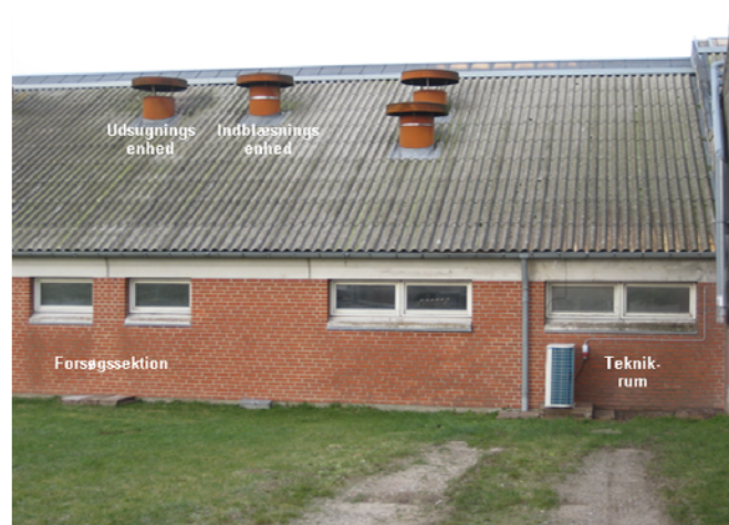
Figur 1. Forsøgsstalden set udefra. Forsøgssektionen ses til venstre og teknikrum med køleanlæg til højre
